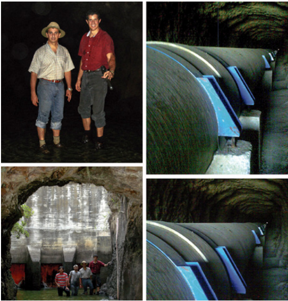
Figura 5. Entubado en el túnel.
