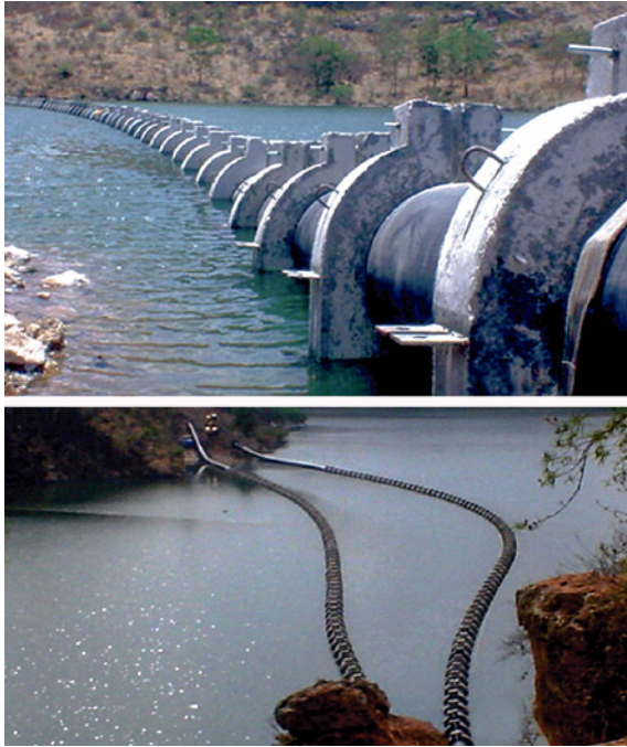
Figura 3. Colocación de cruces de polietileno.
