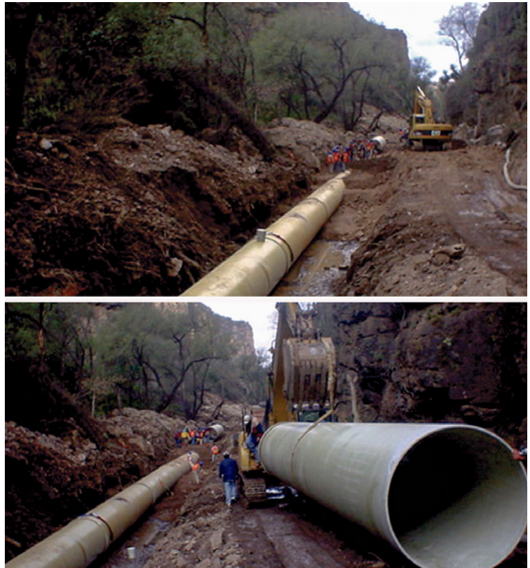
Figura 2. Imagen de tramo de tubo en cañada y detalle de la excavación. A la derecha de la excavadora se ve el muro prácticamente vertical que bordeaba el angosto cauce. Tuvieron que hacerse pequeñas represas provisionales en pares entubando el agua de la represa aguas arriba hasta un punto después de la represa aguas abajo para que se pudiera excavar y enterrar el tubo sin que se inundara la zanja.
